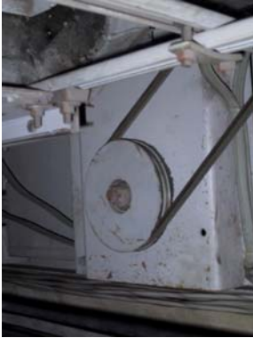
M2 Antrieb vor dem Umbau
